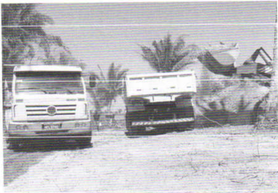
PIÇARRA DE JAZIDA PARA BASE DE PAVIMENTAÇÃO
